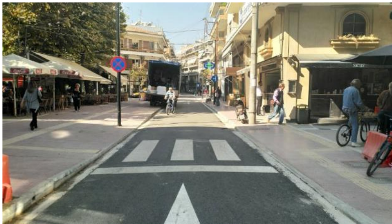
Εικόνα 17: Διαπλάτυνση πεζοδρομίων, οδός Μανδηλαρά , Λάρισα
